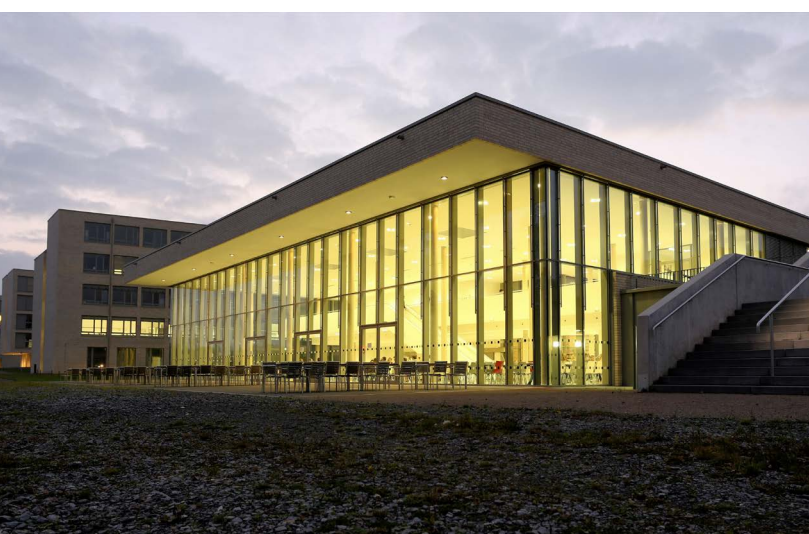
Kantine der Landesschulen NRW von außen
